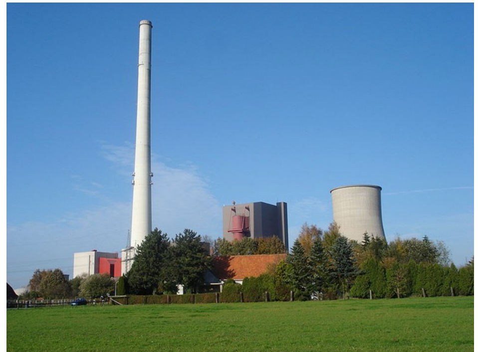
Kohlekraftwerk Ibbenbüren 848 MW
